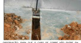
OBSERVAÇÃO: PARA QUE O CABO DE COBRE NÃO ENTRE EM CONTATO COM O CONCRETO, É NECESSÁRIO QUE O ELETRÓDOTO SEJA EMBITULADO ATE ABRIGO DO CONCRETO PARA PROTEÇÃO DO CABO DE ATERRAMENTO
